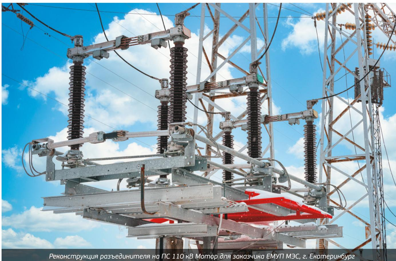
Реконструкция разъединителя на ПС 110 кВ Мотор для заказчика ЕМУП МЭС, г. Екатеринбург
